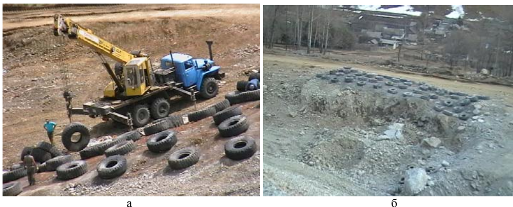
Рис. 2. Укрытие в виде мата из автомобильных шин: а - укладка шин автокраном; б - общий вид укрытия
