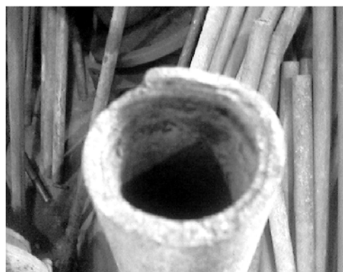
Рис. 1. Фрагменты разрушенных бурильных труб с наружным диаметром 33,5 мм
