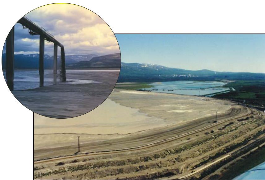
Рис. 1. Вид действующего хвостохранилища АНОФ 2 ОАО «Апатит»
