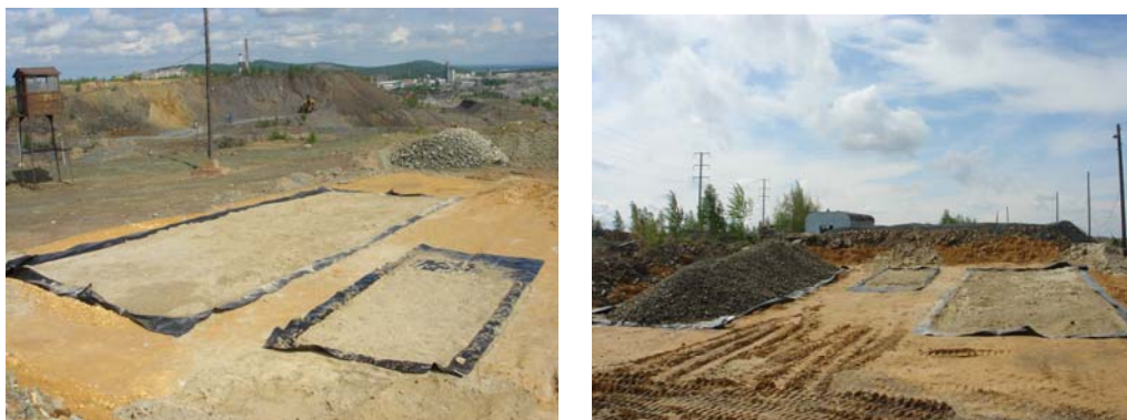
Рис. 2. Внешний вид полигона в период подготовки площадки
