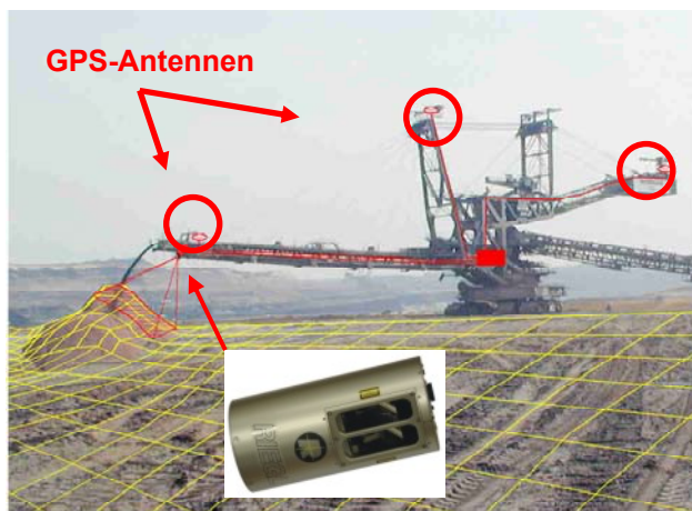
Рис. 9. Создание 3-мерной модели усыпи с помощью GPS и 2- мерного лазерного сканера
