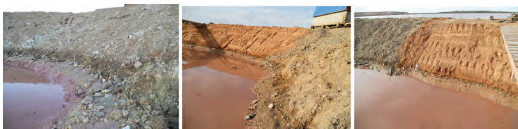
Рис. 5. Последствия акустического осветления оборотной воды на карте намыва: а) низ правого борта, б) низ центра карты, в) низ левого борта
