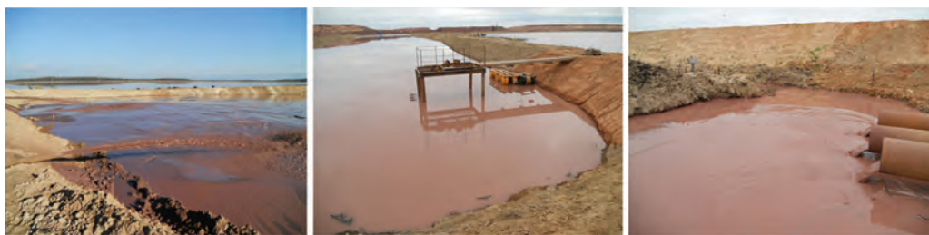
Рис. 1. Внешний вид карты намыва: а) верхняя часть карты, б) нижняя часть карты, в) сливные трубы на выходе
