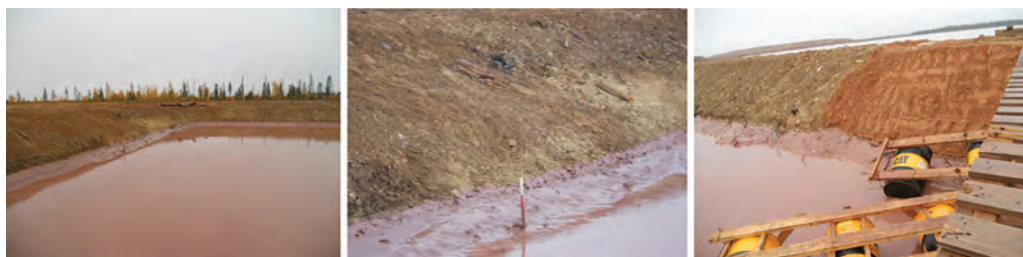
Рис. 4. Последствия гравитационного осветления оборотной воды на карте намыва: а) низ правого борта, б) низ центра карты, в) низ левого борта
