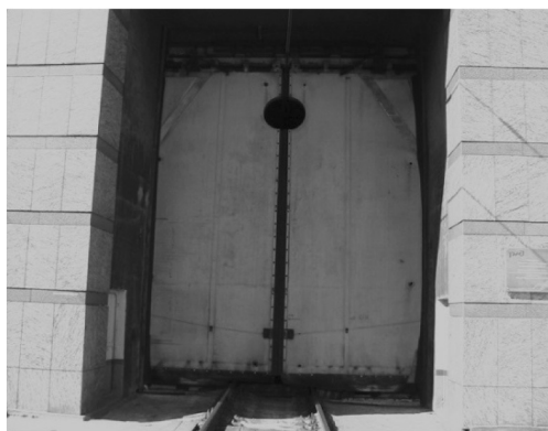
Рис. 1. Внешний вид порталных ворот на Северо-Муйском тоннеле
