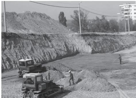
Рис. 1. Откосы: насыпь (а); выемка (б)
