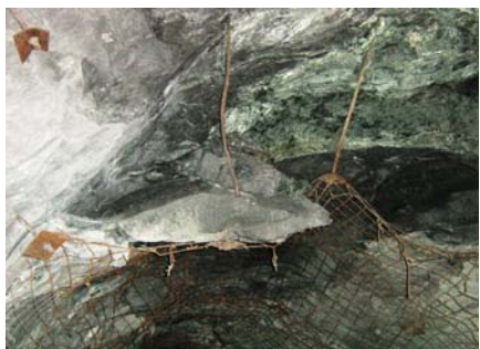
Рис. 6. Нарушения в горных выработках в результате происшедших микроударов: а) — орт 18; б) — орт 19; в) — орт 20; г) — орт 21
