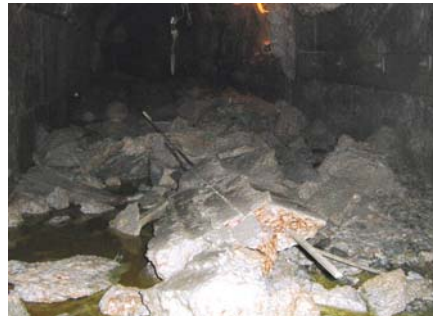
Рис. 6. Нарушения в горных выработках в результате происшедших микроударов: а) — орт 18; б) — орт 19; в) — орт 20; г) — орт 21
