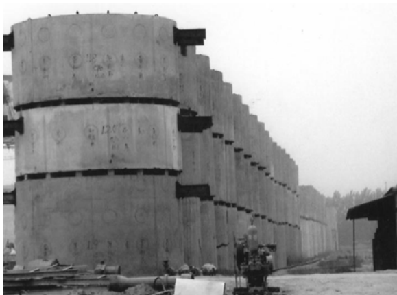
Рис. 3. Секции сталебетонной крепи
