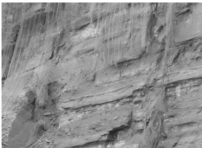
Рис. 1. Участок западного борта (гор. +160 м - +70 м), отрыв блока от массива, вывал 01.08.09 г.
