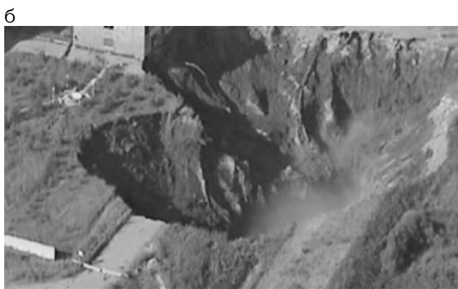
Рис. 1. Деформации выработок подземного рудника и дневной поверхности вследствие несвоевременного заложения выработанного подземного пространства
