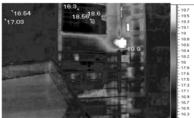
Рис. 3. Термограмма фасада здания (в точках и на шкале цифрами даны значения температуры в °С)
