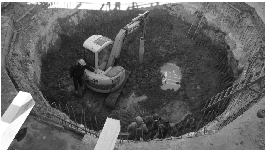
Рис. 6. Работа экскаватора Bobcat 317 на забое ствола
