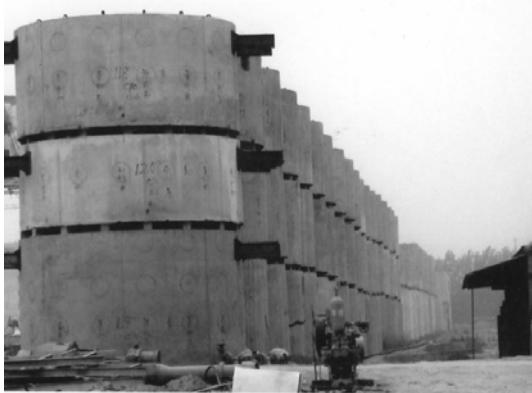
**Рис. 3. Секции сталебетонной крепи изготавленные на месте работ**
