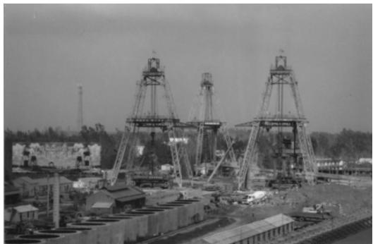
**Рис. 5. Вид площадки строящейся шахты в Китае. Сооружение стволов способом бурения**
