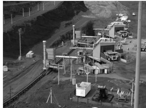
**Рис. 3. Пуск в эксплуатацию циклично-поточного вскрышного комплекса (ЦПВК) на разрезе «Восточный»**
