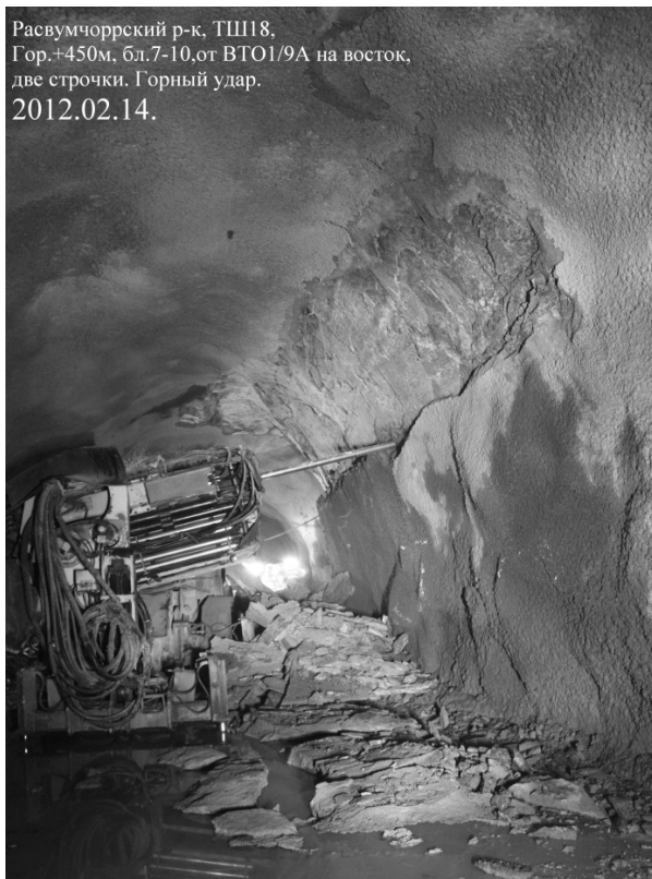
Рис. 1. ТШ 18 после выброса горной массы Фото зам. главного инженера Расвумчоррского рудника по геодинамической безопасности А.В. Пантелеева
