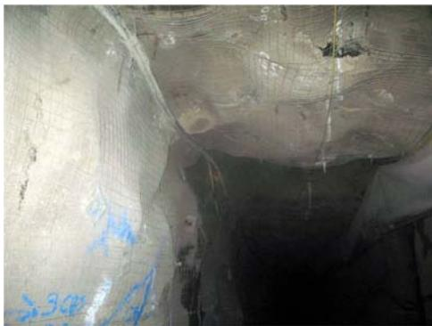
**Рис. 3. Деформирование борта и кровли выработки расположенной на границе шахтного поля подверженной действию опорного давления на руднике в Argyle Diamonds в Австралии**
