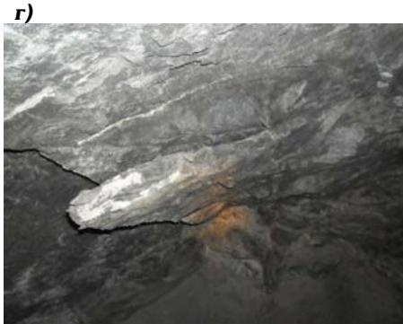
**Рис. 4. Деформирование массива в зонах концентрации напряжений на рудниках Горной Шории и Хакасии: сжатие скважин (а, б, в); заколообразование (г); образование магистральных трещин «Ортлеппа» (д)**
