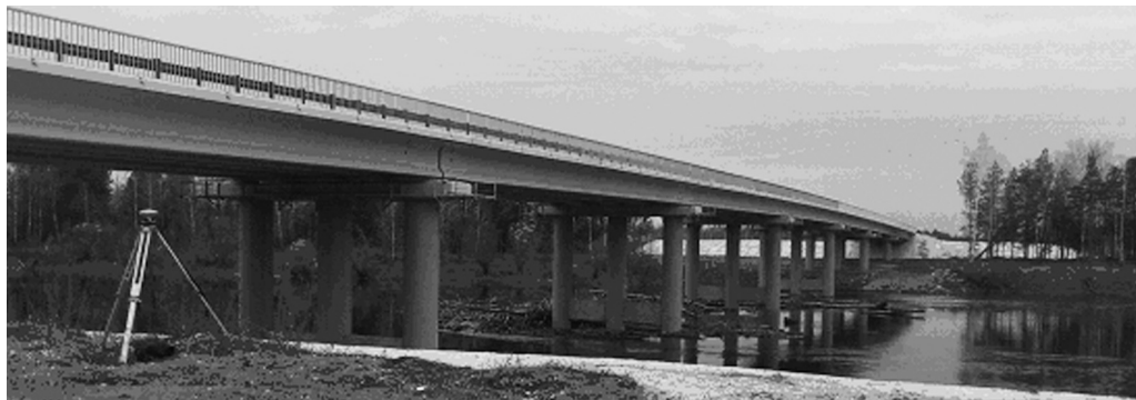
Рис. 6. Мостовой переход после реконструкции
