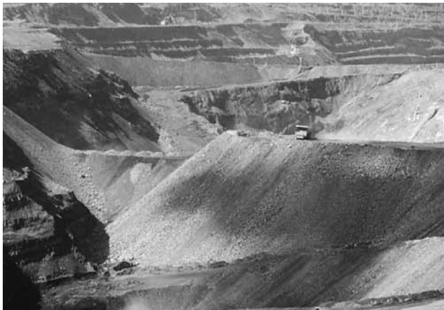
Рис. 4. Второй этап строительства насыпной перемычки с применением бульдозерно-автомобильной схемы отвалообразования
