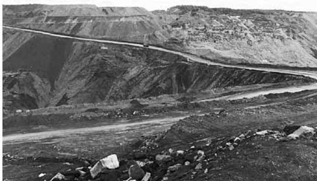
Рис. 6. Положение первой насыпной транспортной (перемычки № 1) со стороны рабочего борта
