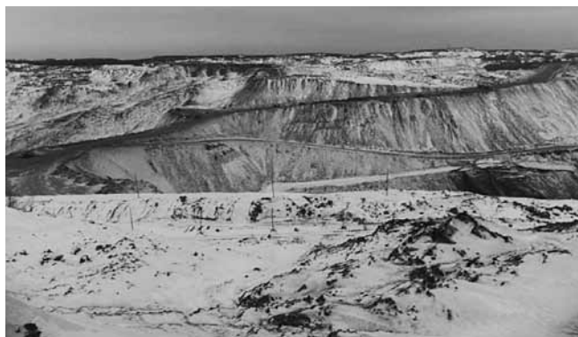
Рис. 8. Положение насыпной транспортной перемычки № 2 со стороны рабочего борта
