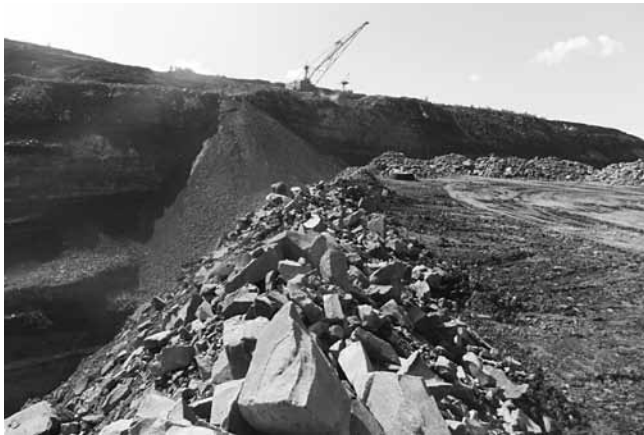
Рис. 3. Первый этап строительства насыпной перемычки
