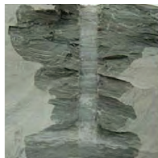
Рис. 8. Поверхность разрушения кембрийской глины
