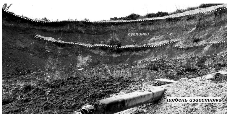
Рис. 1. Развитие техногенного оползня на бортах заброшенного карьера, вызванного смещением массы суглинков по переувлажненным глинам. Выделены стенки отрыва и оползневые цирки
