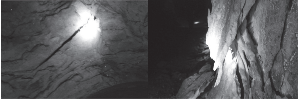
Рис. 3. Отжим массива каменной соли на контуре камер и выработок на глубину до 0,5 м от обнажения с характерным образованием разрывных трещин
