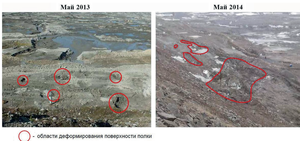
Рис. 1. Динамика деформирования поверхности полки в период май 2013 г. — май 2014 г.
