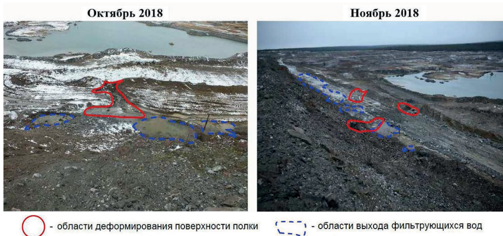
Рис. 3. Вид сверху участка обследуемой дамбы (октябрь–ноябрь 2018 г.)
