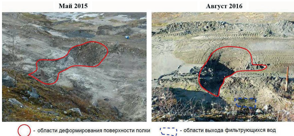
Рис. 2. Кратковременное деформирование полки в мае 2015 г. и августе 2016 г.
