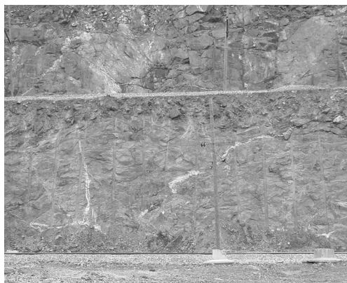
Рис. 1. Раздробленный массив в верхней части уступа
