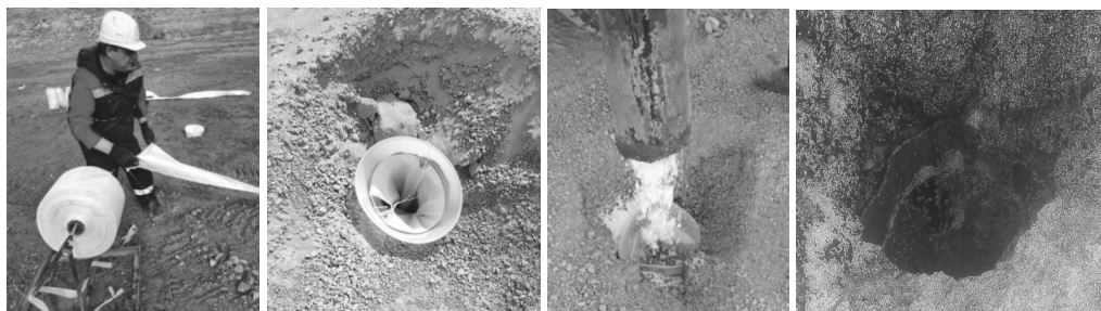
Рис. 10. Формирование заряда с радиальным зазором в сухой скважине Fig. 10. Formation of a charge with a radial gap in a dry well
